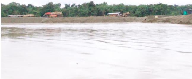
Fotografía 36: Dragas, dragones y retroexcavadoras.
