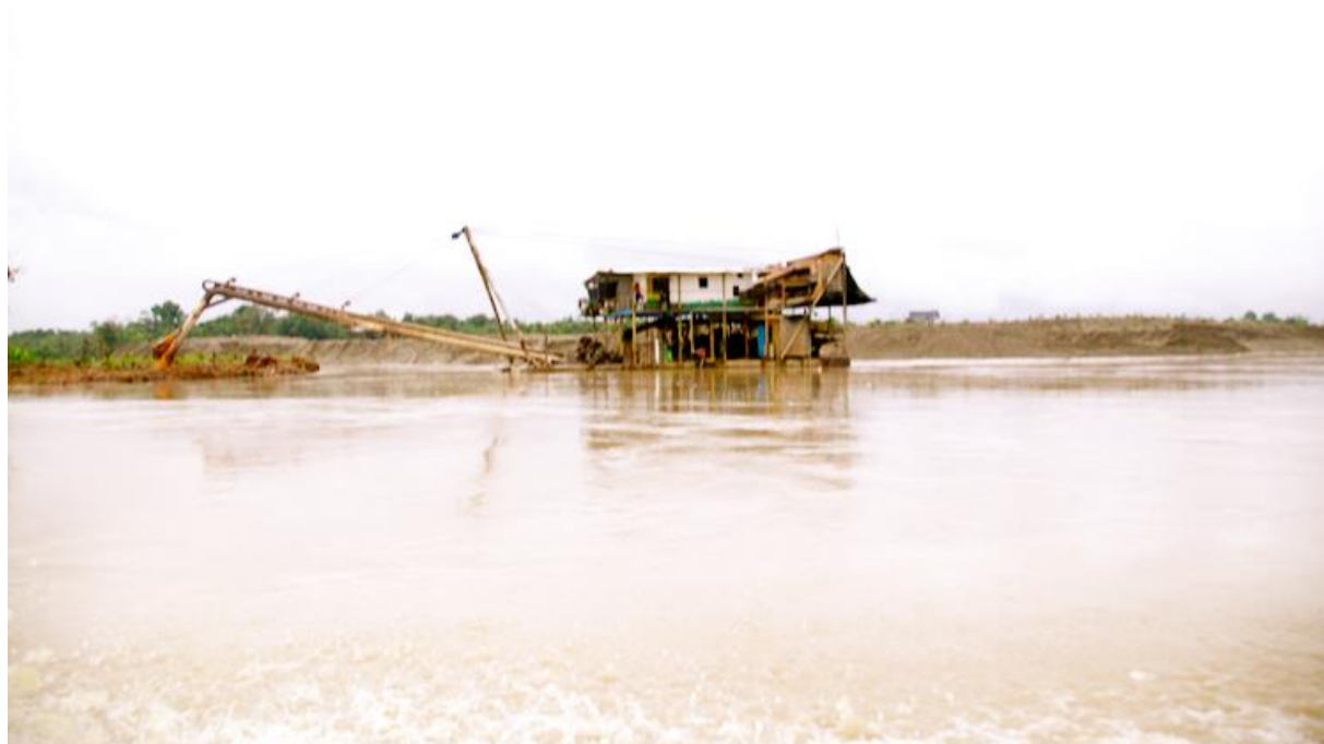
Fotografía 68: “Dragón” en operación
